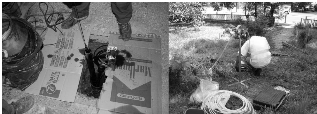
Fig.8 Recoltare hidrocarburi în stare liberă
