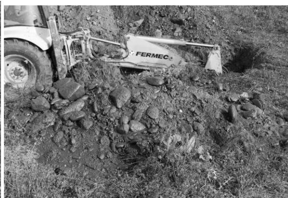
Fig. 3 Execuție șanț de investigare
